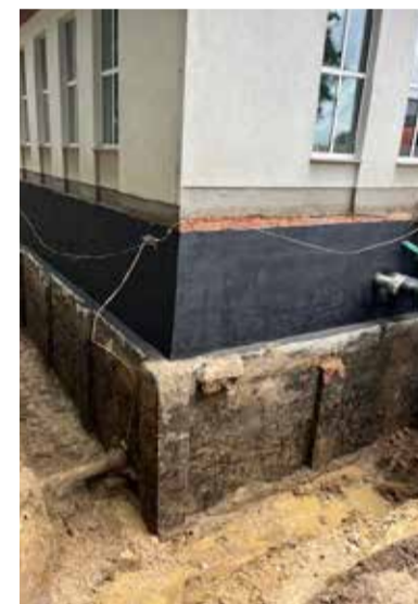
Das Wasserwerk in Pasewalk wurde vor gut 100 Jahren erbaut. Nun galt es, an einem Teil das Fundament freizulegen, um eine Sperrschicht gegen eintretendes Wasser anzubringen. Dabei wurde bis zu 5 Meter tief gegraben. Fotos: ZVG
