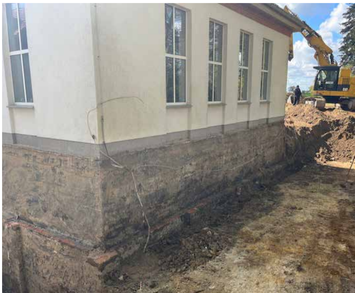
Das Wasserwerk in Pasewalk wurde vor gut 100 Jahren erbaut. Nun galt es, an einem Teil das Fundament freizulegen, um eine Sperrschicht gegen eintretendes Wasser anzubringen. Dabei wurde bis zu 5 Meter tief gegraben. Fotos: ZVG
